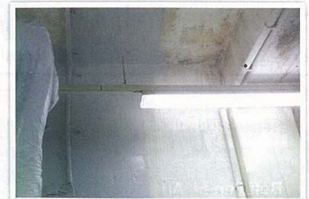
Der Grundanstrich kann direkt auf befallene Flächen aufgetragen werden und schließt Biomasse ein
