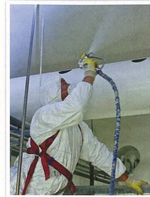
Das Aufbringen von Bioni Hygienic erfolgt im Sprühverfahren
